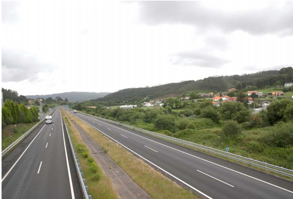
Autovía A-6 ao seu paso pola parroquia de Orro
