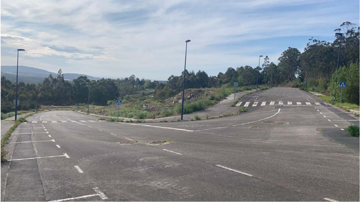
CRUCE RUA VICTORIA KENT CON RUA JUANA CAPDEVIELLE
