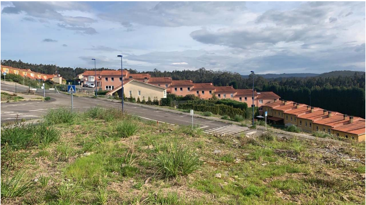
VISTA DESDE LA PARCELA 148 HACIA EL CRUCE RUA VICTORIA KENT CON RUA JUANA CAPDEVIELLE
