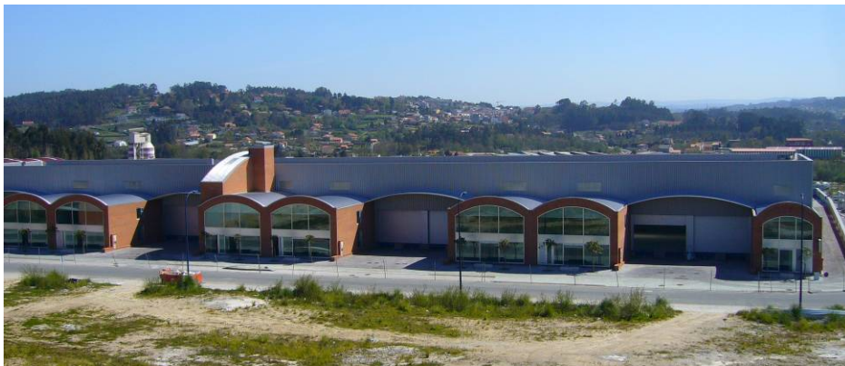
Polígono Empresarial de Alvedro, en construción
